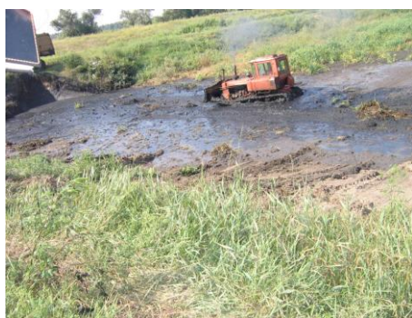
Рисунок 2 – Состояние иловых карт при повышенной влажности сырого осадка (на примере очистных сооружений г. Днепропетровска)
