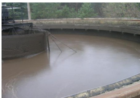
Рисунок 1 – Общий вид илоуплотнителя (на примере очистных сооружений г. Днепропетровска)
